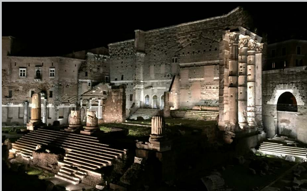
Fori Imperiali, Rome. Lighting design: Vittorio Storaro, Rome; Francesca Storaro, Castel Gandolfo. Photography: Vittorio Storaro, Rome / Castel Gandolfo.
