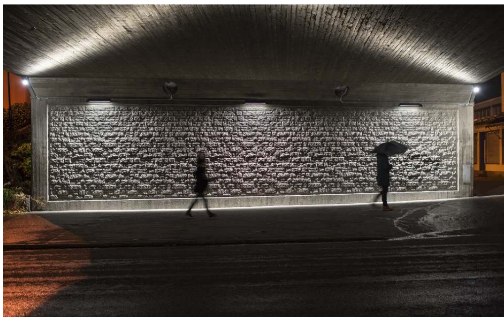
Engelbrektsväg Tunnel, Stockholm. Photography: Johan Elm, Stock- holm.
