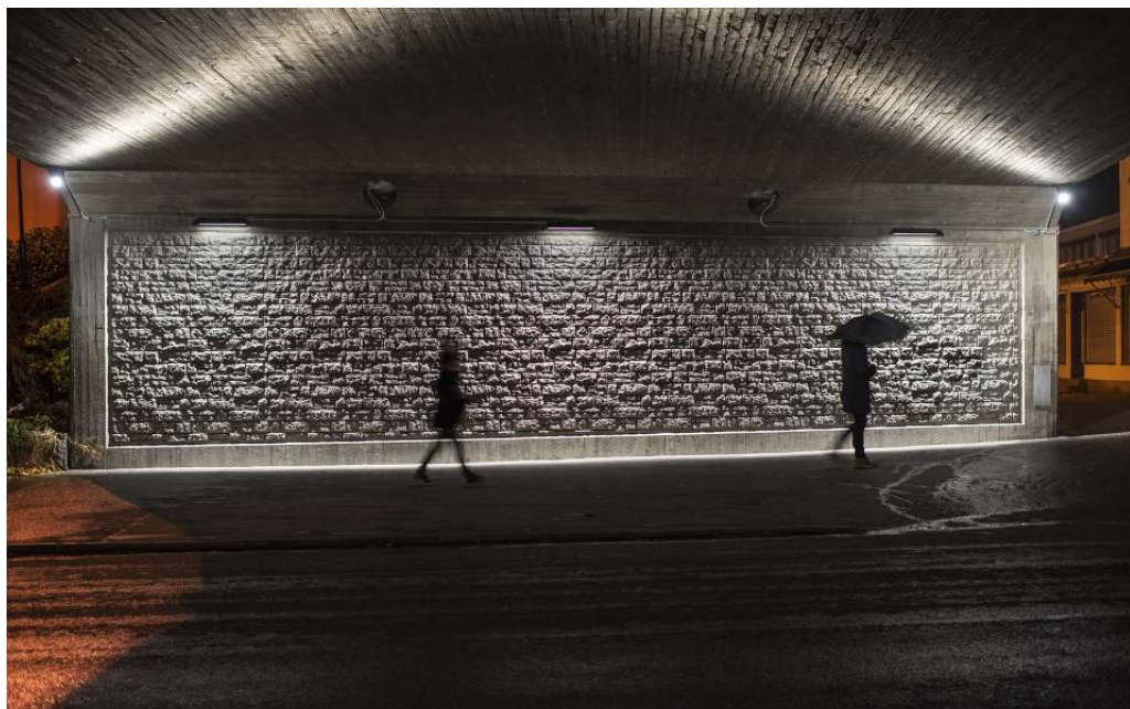
Tunnel Engelbrektsväg, Stockholm. Fotografia: Johan Elm, Stoccolma.
