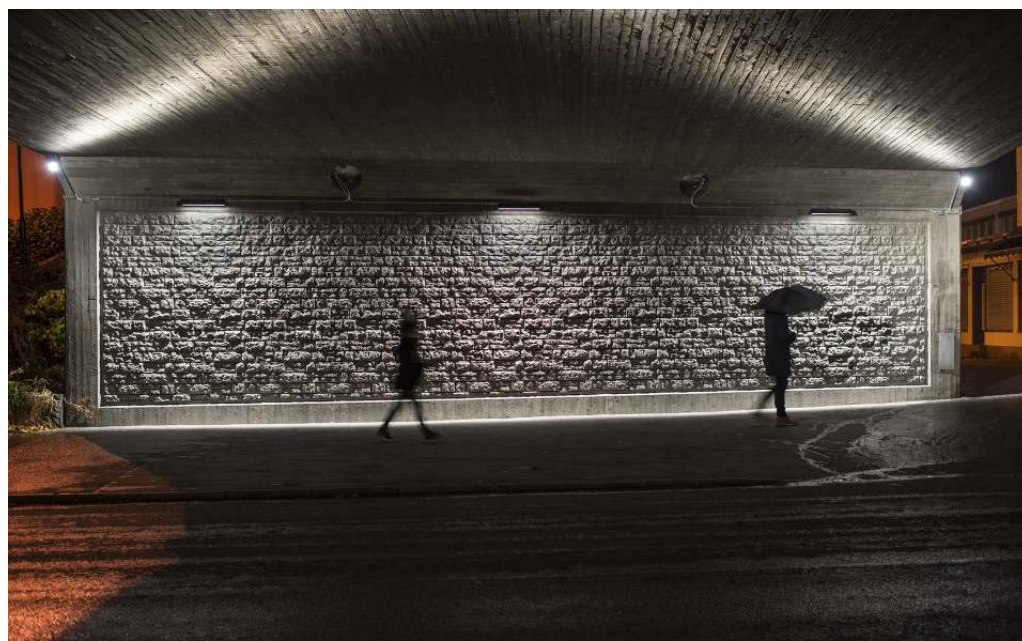
Tunnel Engelbrektsväg, Stockholm. Photographie : Johan Elm, Stockholm.
