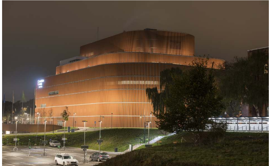
Central energética de Exergi, Estocolmo. Arquitectura: Urban design, Estocolmo. Fotografía: Johan Elm, Estocolmo.
