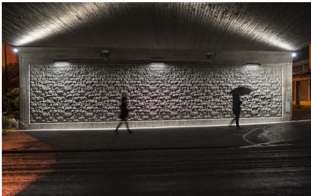
Túnel de Englebrevtsväg, Stockholm. Fotografía: Johan Elm, Estocolmo.
