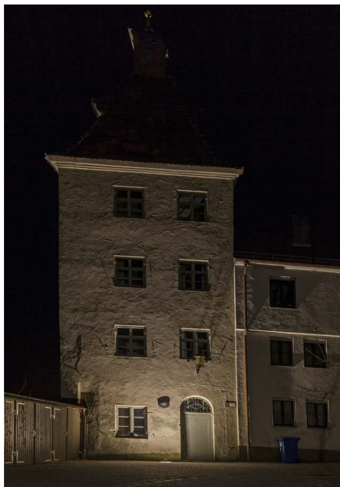
Torre Ursula, Günzburg. Progettazione illuminotecnica e dell'impianto elettrico: Conplanning GmbH, Ulm. Fotografie: Dirk Vogel, Dortmund.
